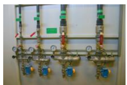
Verteilung Dichtheitsprüfung
